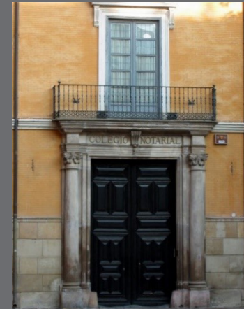
12 a Fachada del Colegio Notarial de Aragón
